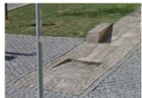
insprace - vedení potoka v dlažbě, vpust
