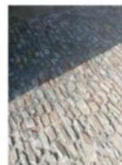
insprace - šlitová dlažba
