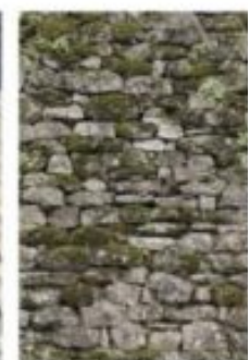
insprace - prorostlá dlažba
